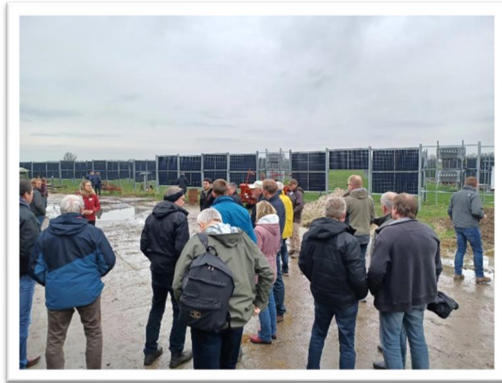
Abbildung 11: Agri-PV-Anlage mit bifazialen Modulen in Culemborg (NL); Bildquelle: GLZ 2023
