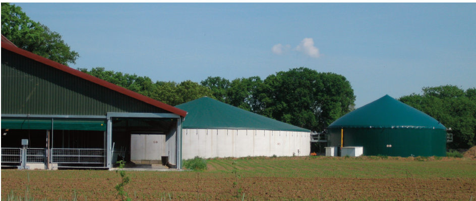
Abbildung 10 Gülle möglichst schnell in die gasdichte Biogasanlage überführen – das senkt die Treibhausgasbelastung und verbessert die Biogasausbeute
